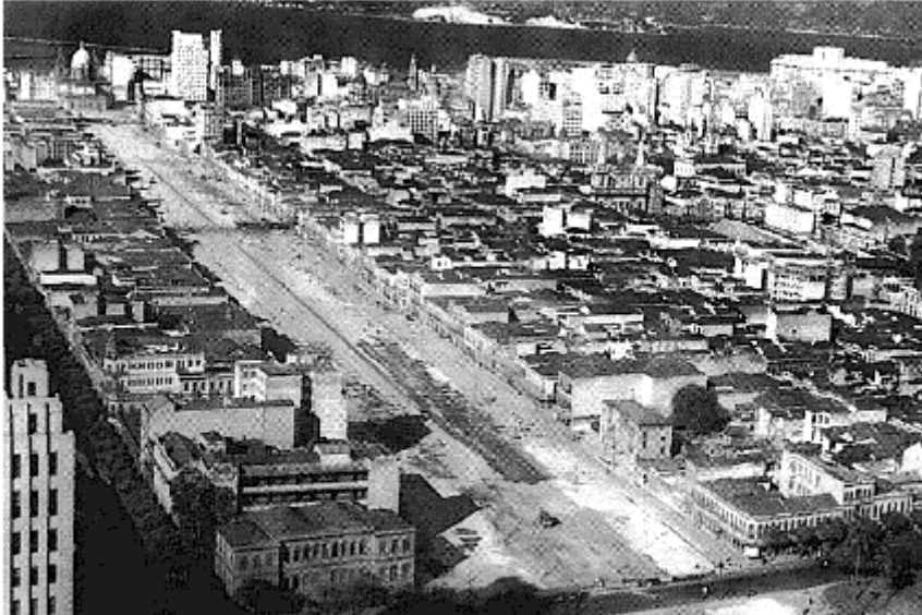
Construção da avenida Presidente Vargas
