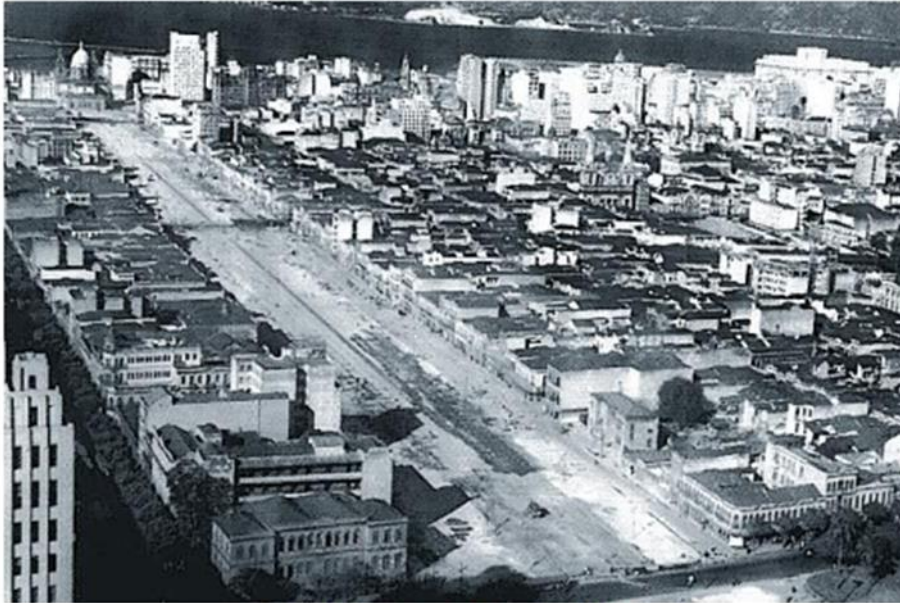
Construção da avenida Presidente Vargas
